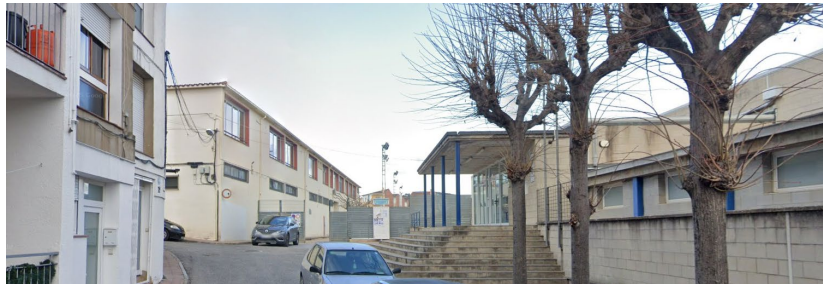
Vista de l'àmbit des del carrer de la Piscina
